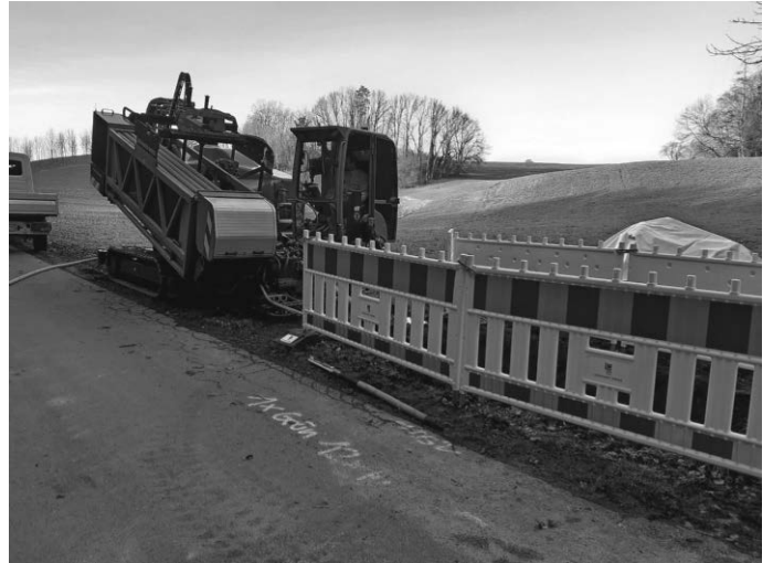
Spülbohrgerät zur Verlegung der Leerrohre in geschlossener Bauweise.
